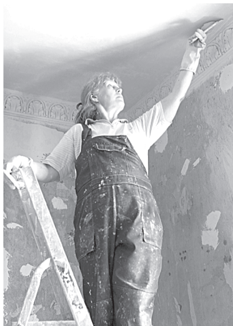
В квартире Галины Шабалиной заканчивает работу маляр-штукатур.
