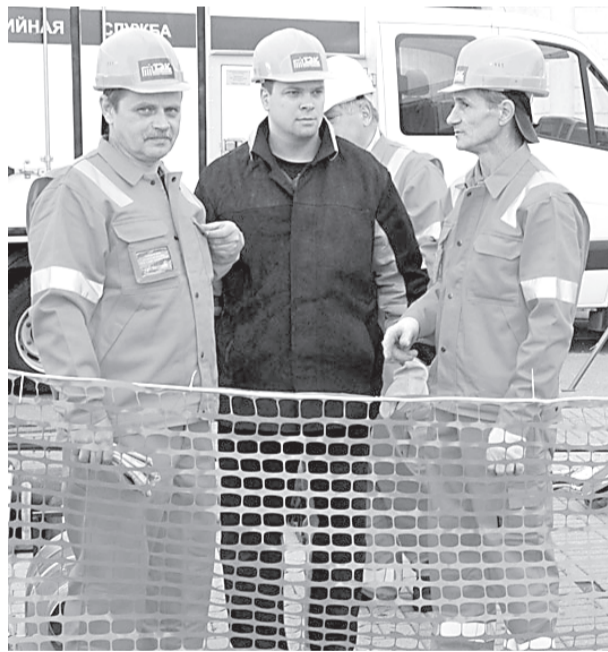
Новая спецодежда пропитана огнезащитным составом и снабжена светоотражающими полосами, а сетчатое ограждение оборудовано световыми маячками.
