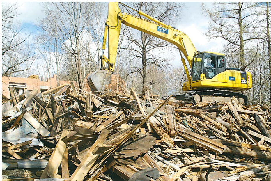
Апрель 2011 года: в выходные дни экскаватор уже растаскивает бревна. Утерянный дом был возведен в 1900-е гг. архитектором С. А. Данини.
