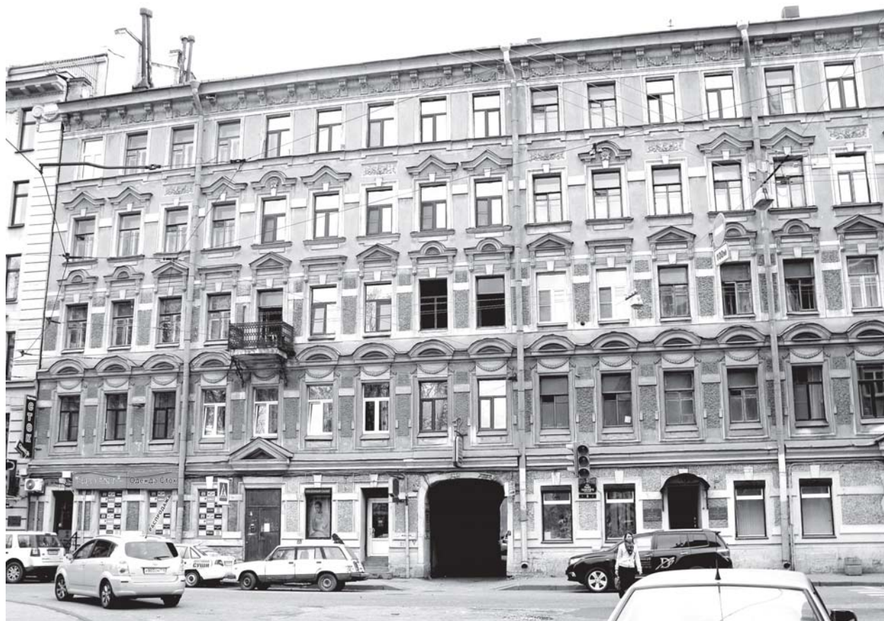
Никак не поддается ремонту злополучная крыша в доме на улице Льва Толстого!
