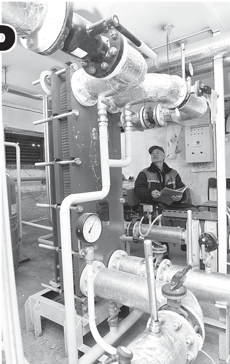
Домовые узлы учета ставятся для одной цели — чтобы жильцы оплачивали только то тепло, которое потребляют.
