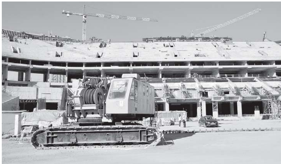
Остатки гусеничного крана — первое, что бросается в глаза на бетонной площадке будущего футбольного поля.
