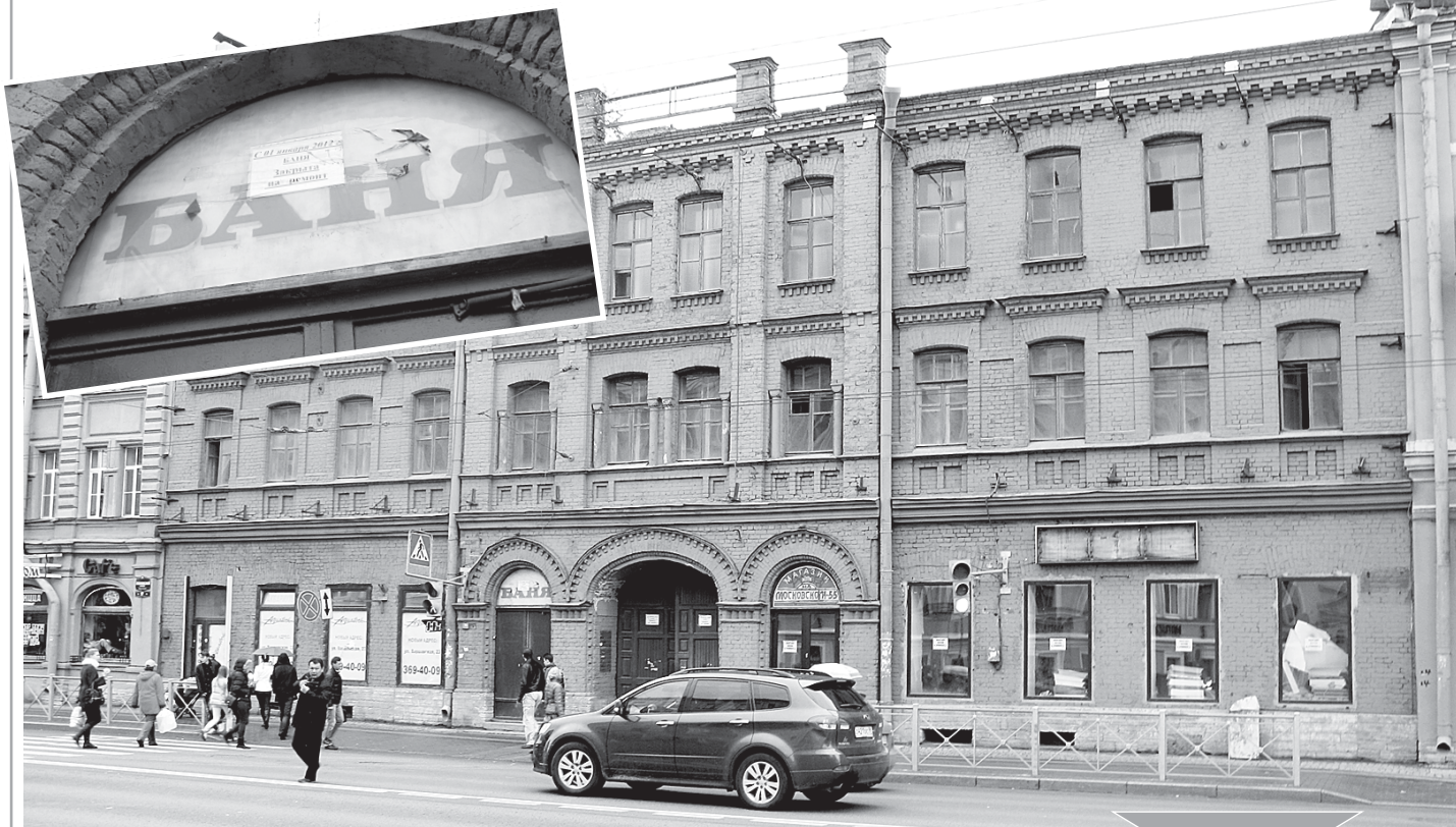
За историческим фасадом кипит перестройка.
