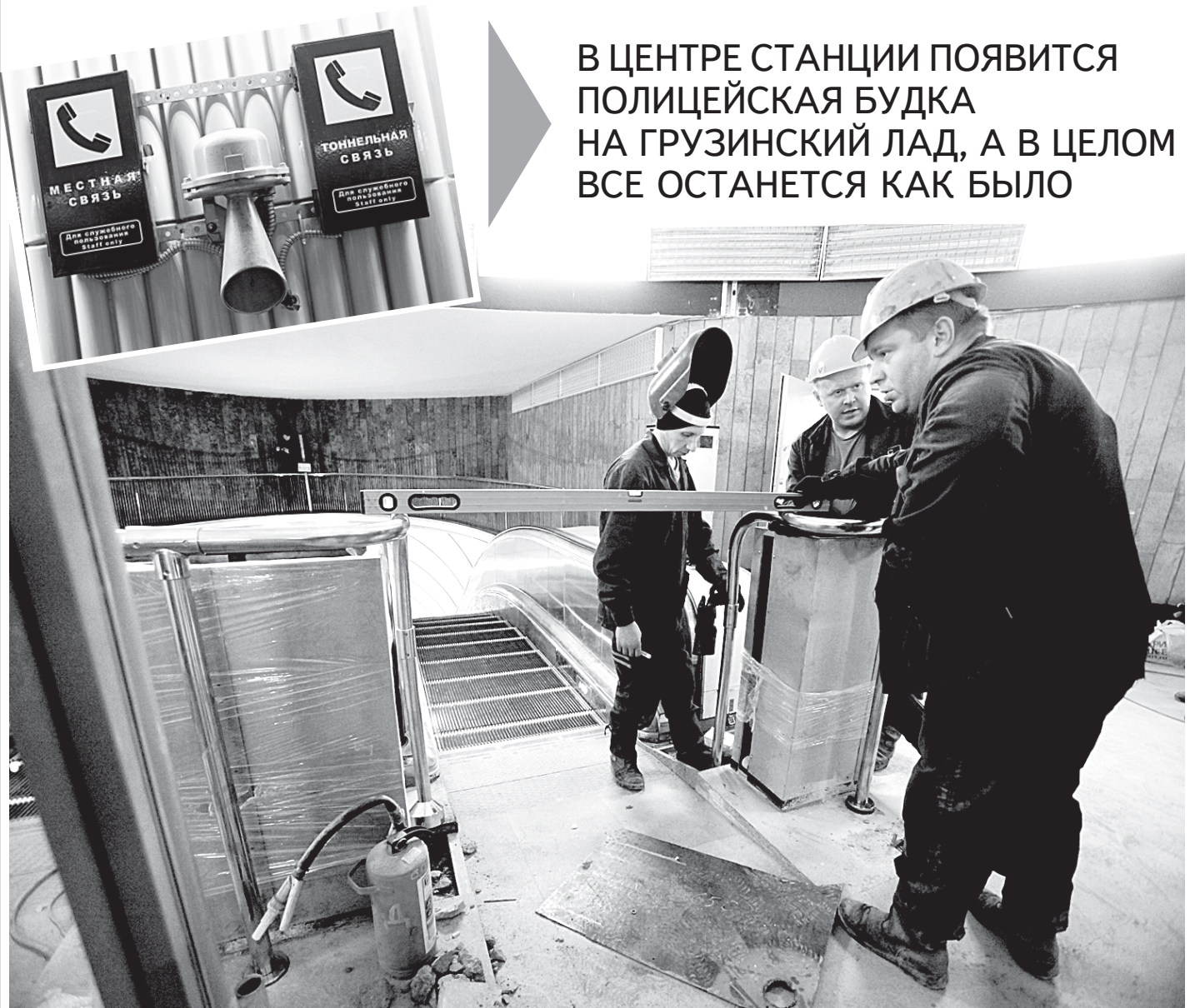
Ремонт наклонного хода «Петроградской» — главный итог реконструкции станции, длившейся почти год.
