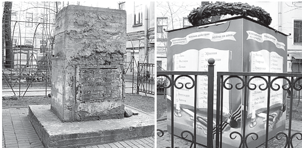
Это не опустевший постамент — это вентиляционная шахта бомбубежища.
