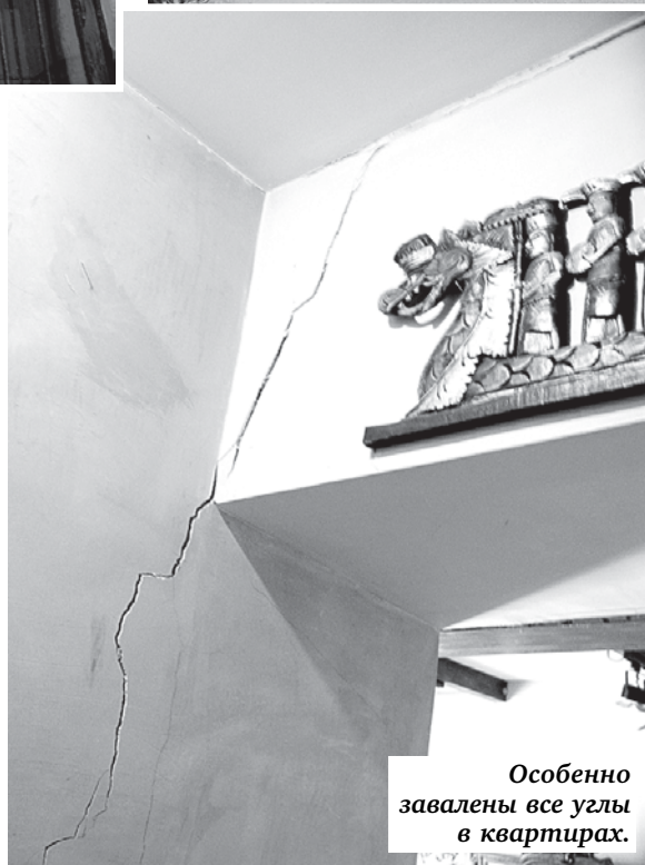
9 апреля поставили новые маячки на трещинах, с осени ставших сквозными.
