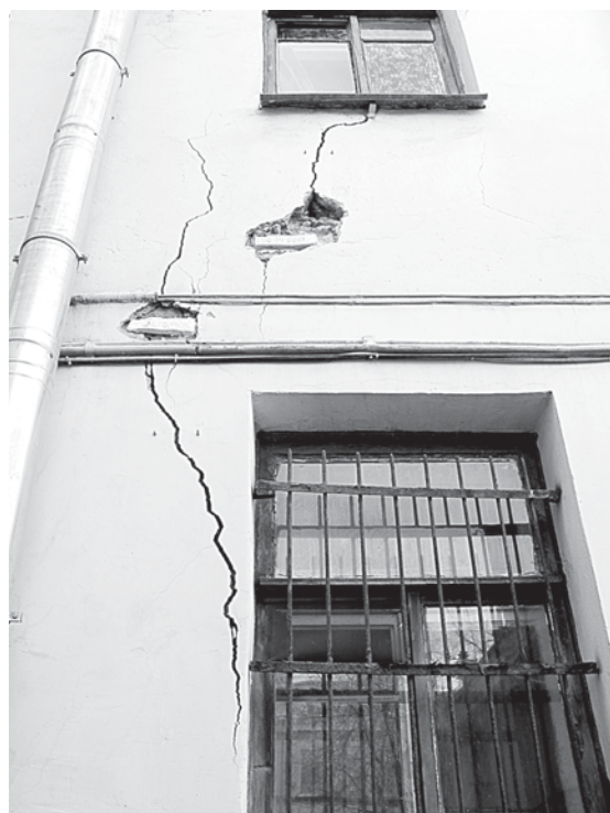
9 апреля поставили новые маячки на трещинах, с осени ставших сквозными.
