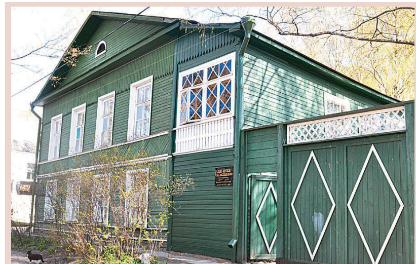
Дом Достоевских на берегу реки Перерытицы.
