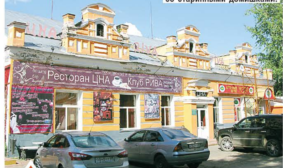
Аршинные вывески не церемонятся со старинными домишками.
