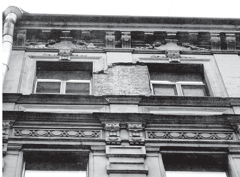
Фасад по улице Восстания...
