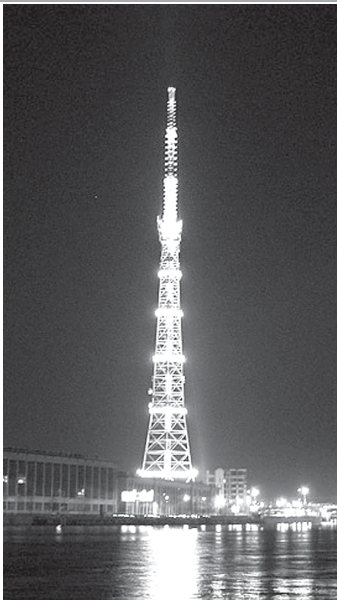
До 30 ноября 1500 газоразрядных ламп-вспышек заменят на светодиодные стробоскопы.
