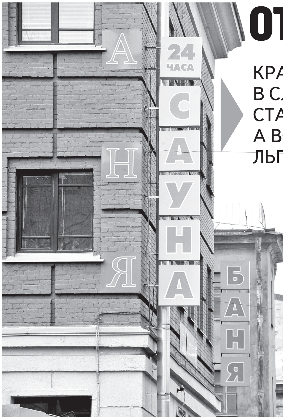
Воронежские бани недавно открылись после ремонта...
