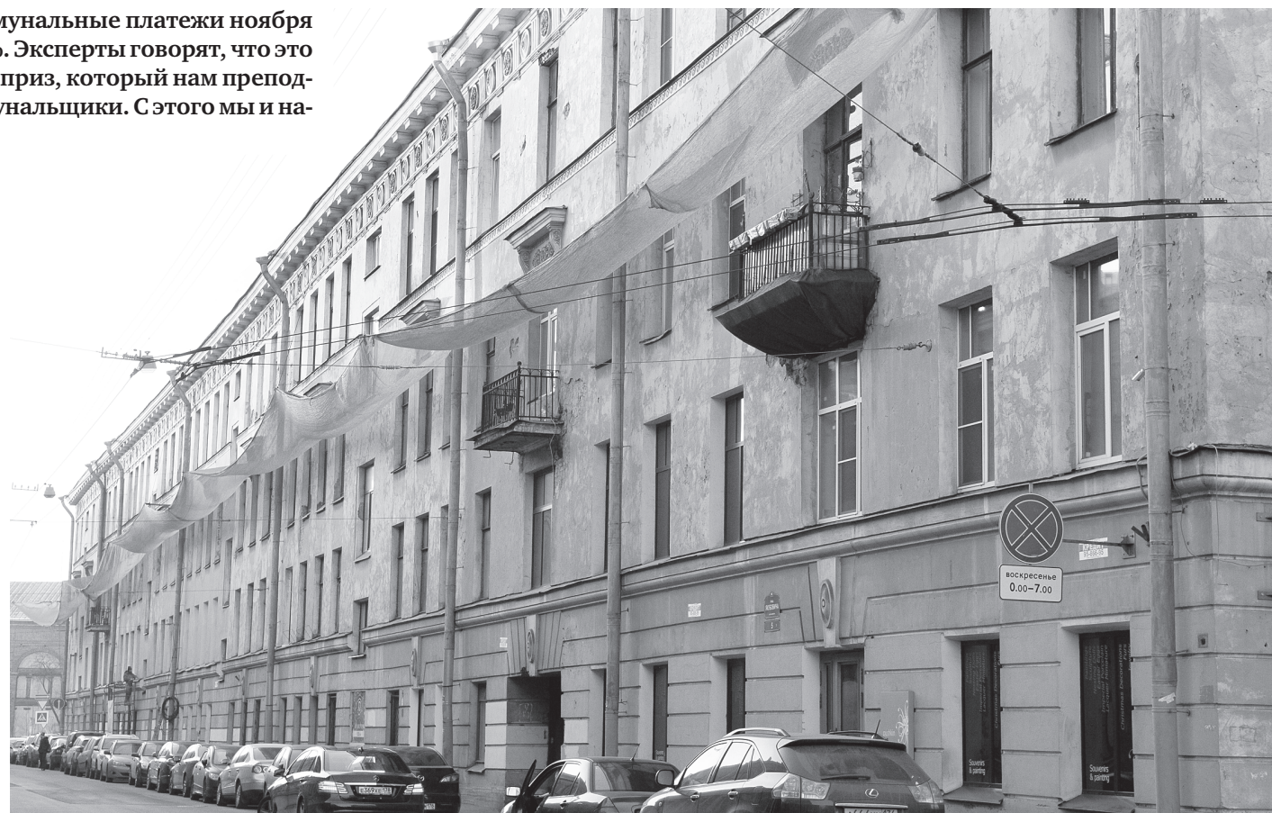
Дома в центре требуют больших затрат на капитальный ремонт.
