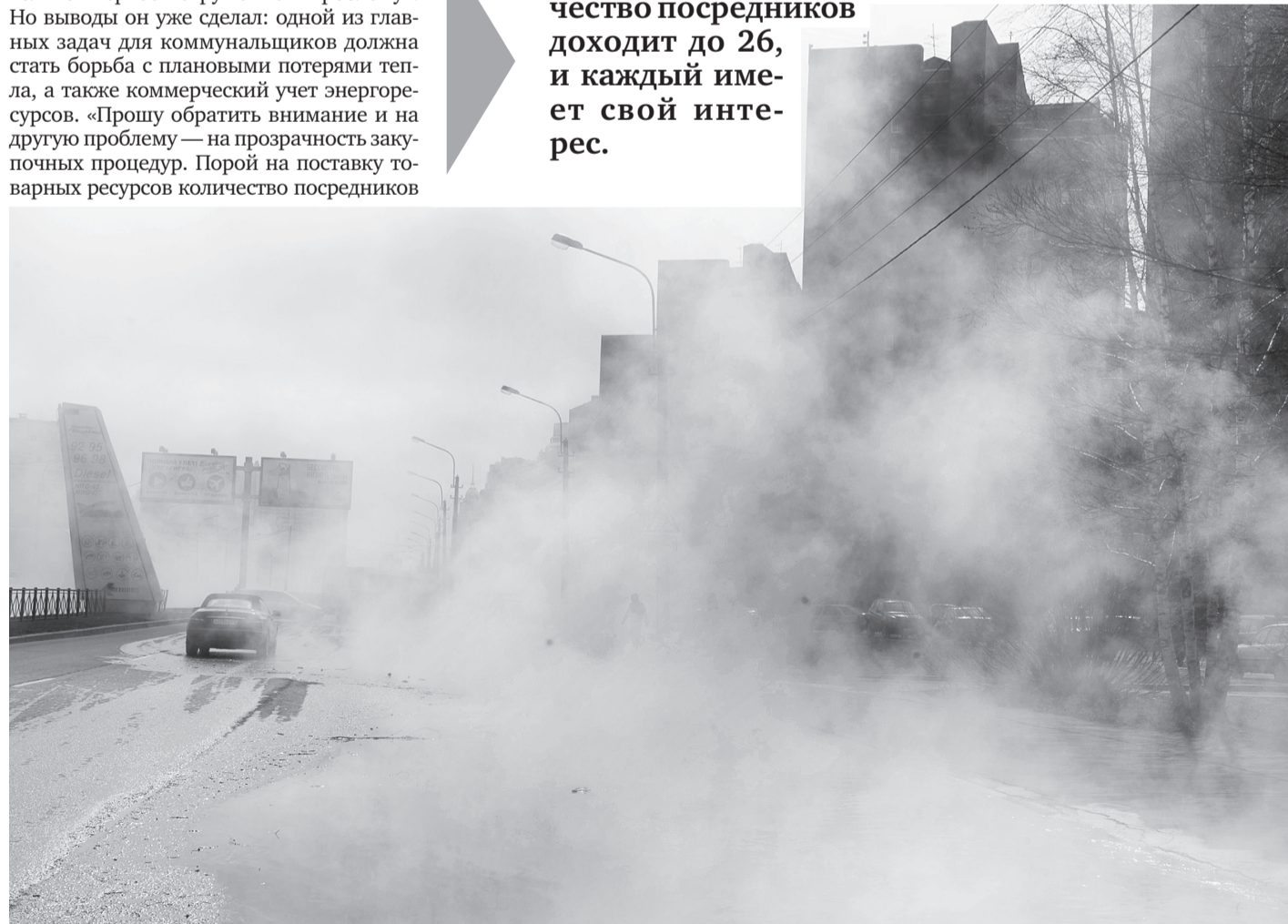
Горожане уже устали от постоянных коммунальных аварий, связанных с плохим состоянием трубопроводов.
