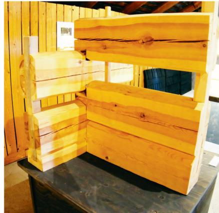
Образец из галереи Pro Pucc в Лахти показывает способ соединения бруса при строительстве домов.
