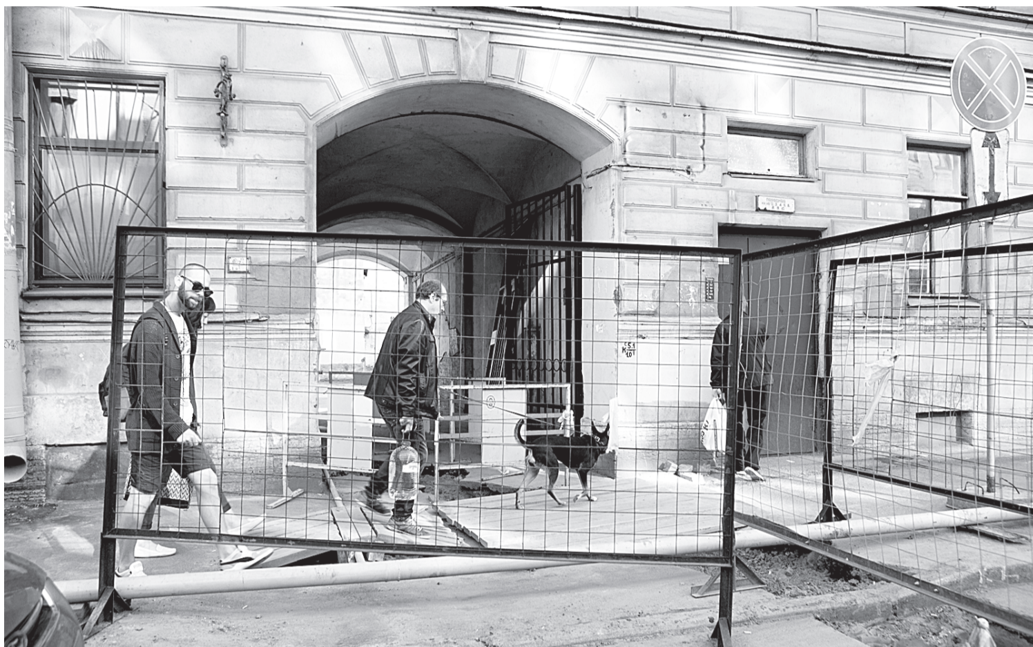
Согласованные аварийные работы, незаконные работы, ремонт дороги, прокладка газопровода...
