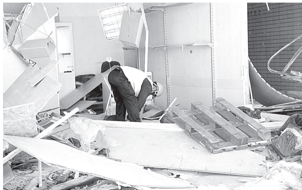
Рабочий демонтирует торговый павильон.
